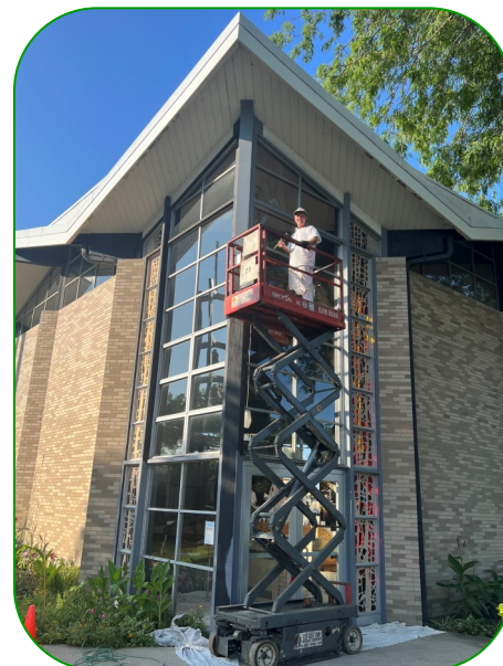
JSB Painting LLC rozpoczyna czyszczenie i malowanie zardzewiałych metalowych belek przy wejściach kościelnych.
